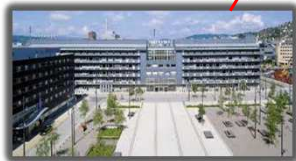
Technopark Zürich, Hauptsitz
